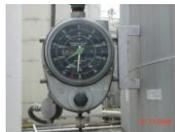
図4: 浮子式レベル/容量指示計
